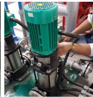
Checking and evaluation for pump operation Kiểm tra đánh giá hư hại và đo đạc các thông số vận hành
