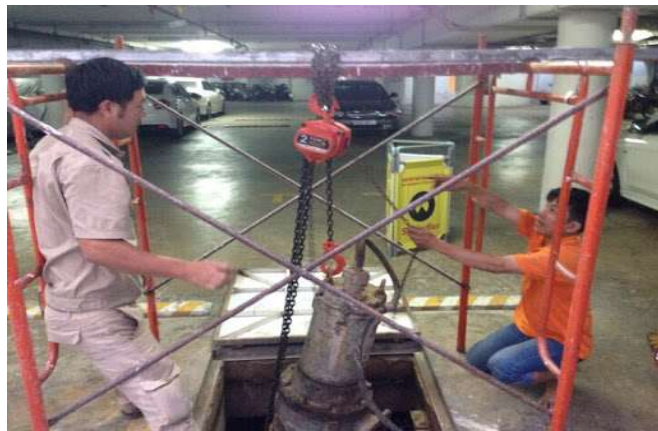
Checking and evaluation for pump operation Kiểm tra đánh giá hư hại và đo đạc các thông số vận hành
